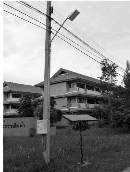
ภาพที่ 7 ไฟถนนพลังงานแสงอาทิตย์หลอด LED
