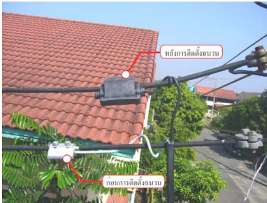
ภาพที่ 6 การประกอบฉนวนข้อรัดสายไฟฟ้า
