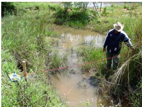
ภาพที่ 5 การสำรวจ ลำน้ำ กำหนดจุดก่อสร้างฝาย
