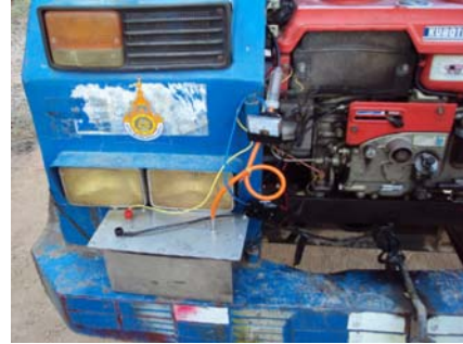
ภาพที่ 6 การติดตั้งชุดแยกก๊าซไฮโดรเจนกับตัวเครื่องยนต์
