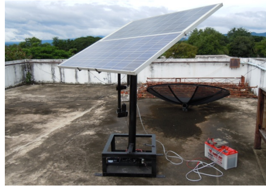
ภาพที่ 8 ระบบเมื่อติดตั้งแผงเซลล์แสงอาทิตย์
