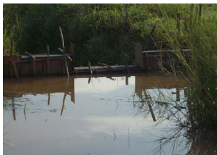
ภาพที่ 6 การก่อสร้างฝาย
