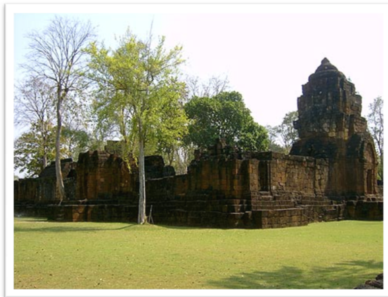
รูปที่ 2 การนำหินศิลาแลงมาใช้สร้างปราสาทหิน
