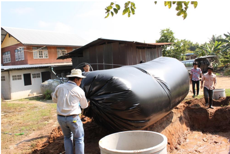
ขั้นตอนที่ 6 นำถุงลงหลุมและจัดวางถุง
