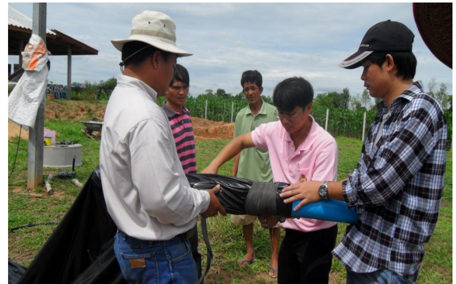
ขั้นตอนที่ 4 มัดปลายถุงกับท่อ พีวีซี 4 นิ้ว ด้วยยางในรถจักรยานยนต์
