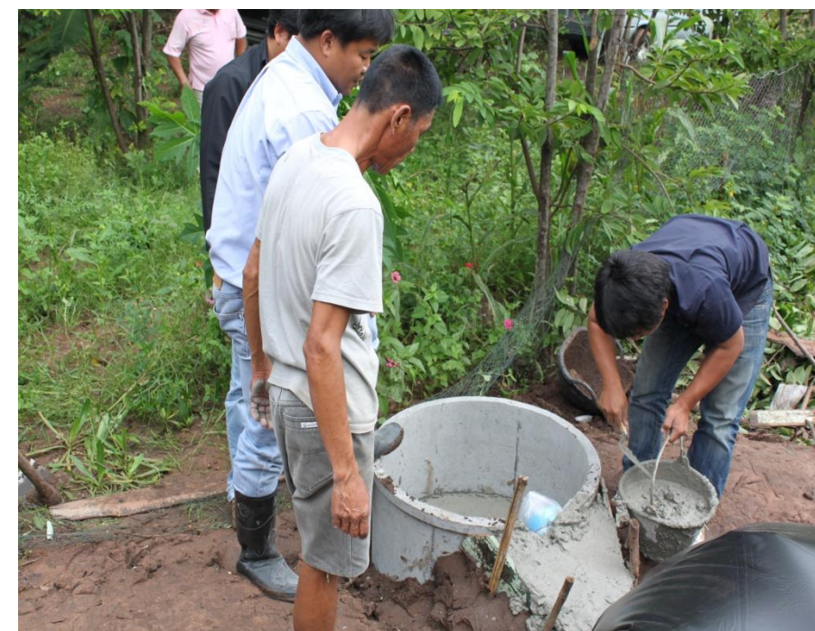
ขั้นตอนที่ 7 ทำบ่อทางเข้าของมูลและบ่อล้น ที่ปลายท่อพีวีซีทั้งสองด้าน
