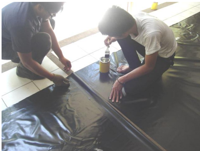
ขั้นตอนที่ 2 ติดแผ่นพลาสติกพีวีซี จำนวน 3 ชิ้น เข้าด้วยกันตามยาว
