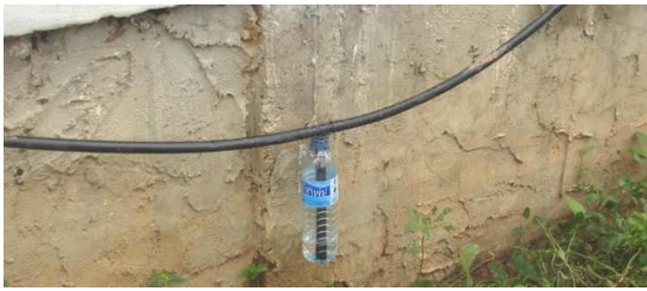
ขั้นตอนที่ 8 ประกอบสายส่งก๊าซ/ติดตั้งขวดปรับแรงดันและดักน้ำ
