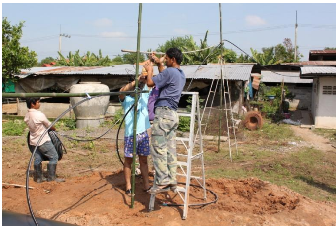
ขั้นตอนที่ 9 ติดตั้งท่อส่งก๊าซและวาล์วควบคุมก๊าซ
