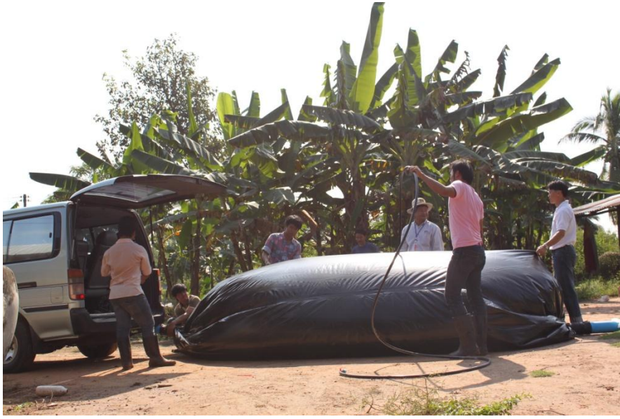
ขั้นตอนที่ 5 ทดสอบการรั่วของถุงด้วยไอเสียรถยนต์
