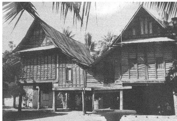
ภาพ เรือนพื้นถิ่นโคราชเรือนนอนทางซ้ายฝาปรือกรูเซงดำ
